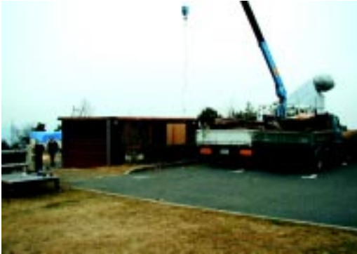
サテライト休憩小屋の取り壊し作業。長い間、ありがとうございました！
