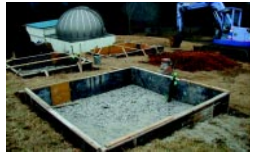
サテライト、ファミリードーム移設先の土台。電気やインターネットの配線が通るパイプがわかります。左はKカメラドーム。
