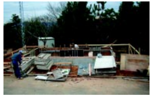
新しいサテライト休憩小屋の建設予定地。おしゃれな小屋ができますよ。
