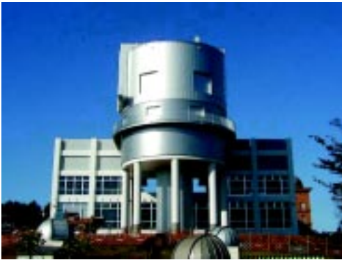
スリットが西を向いている状態。10月19日に南側より撮影
