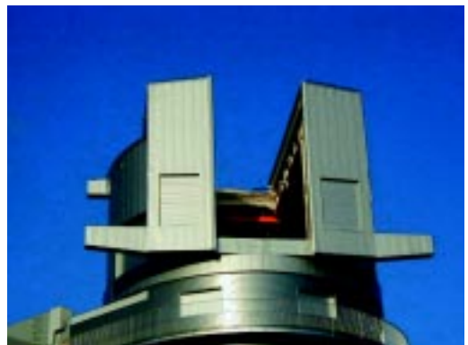
スリットが開いて西を向いている状態。11月4日。赤い部分はクレーンのレールです
