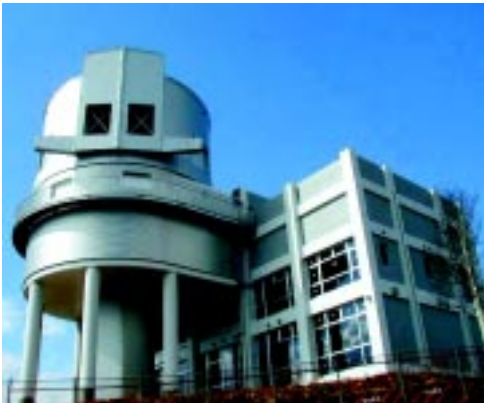
スリットが南東を向いている状態。10月23日に南東より撮影
