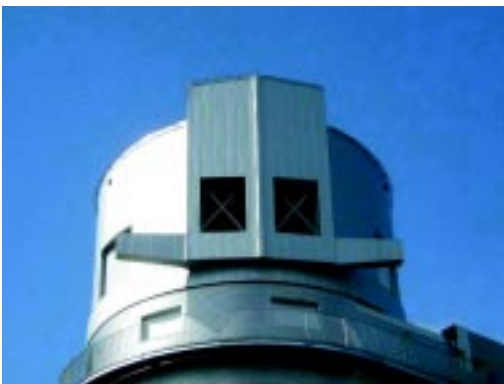
エンクロージャーの拡大。外壁についている窓は、放熱用でパンチレーターと呼ばれます
