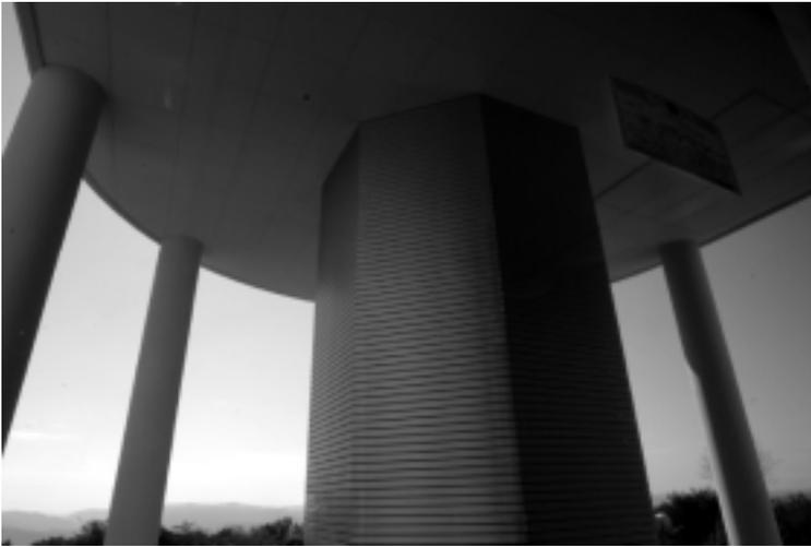
写真1：ピラーと呼ばれる新天文台で最も太い柱。覆（おお）いがされていて、柱のコンクリートがむき出しになっていないことに注意
