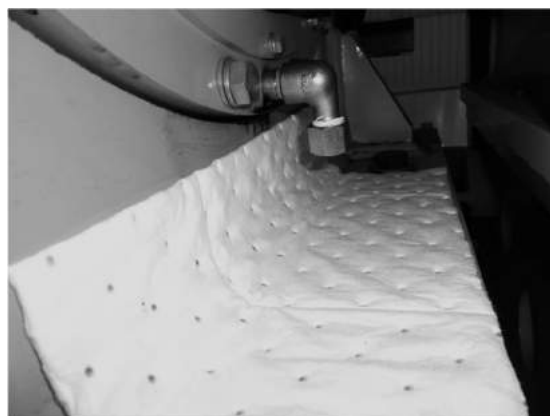
図 3.3.2:油吸着シート設置
