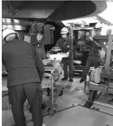
図 2 モーター交換風景
