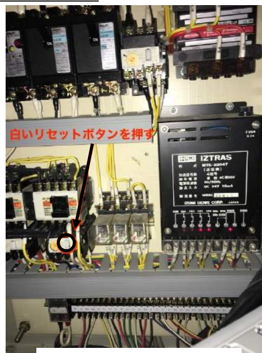
図 1 主電函内のサーマルトリップ
