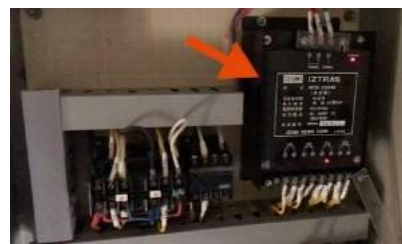
図 2 副電盤中の多重伝送システム
