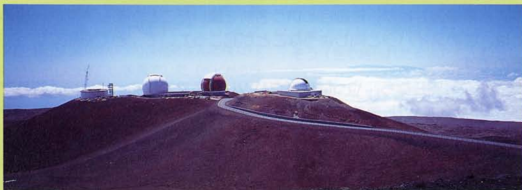
左から、建設中のすばる、KECKI, KECKII (建設中), IRTF。彼方にマウイ島が見える。
