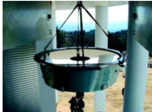
セルごとクレーンで、新天文台の観測室につり上げられました。重量はセルを含めて2.7 t あります。F1.5なので、鏡面がずいぶんとかぼんでいます
