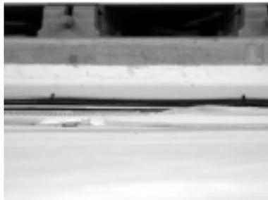
写真2：ピラーの上端部。上は望遠鏡設置前に撮ったピラーの上面。金属の円盤で建物の床とつながっているように見えるが、実は下を見てもらえばわかるように床と円盤の間には隙間が空いています
