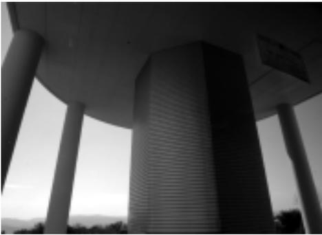
写真1：ピラーと呼ばれる新天文台で最も太い柱。覆（おお）いがされていて、柱のコンクリートがむき出しになっていないことに注意
