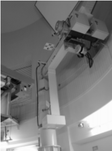
写真1: 2m望遠鏡のある観測室にすえられた3トンポストジブクレーン
