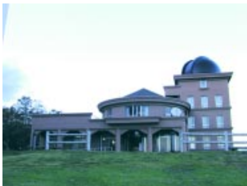
写真3：リニューアル改修工事を終え、外装もきれいになって夜を待つ天文台北館。以前よりも明るい色調になっています
