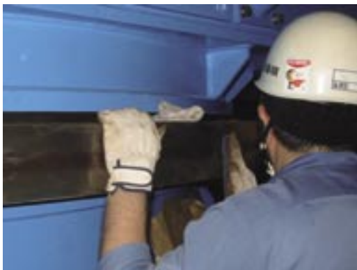
図2：油を塗ることができず、さびてしまう部品には、紙やすりを使ってさびをていねいに落としていきます
