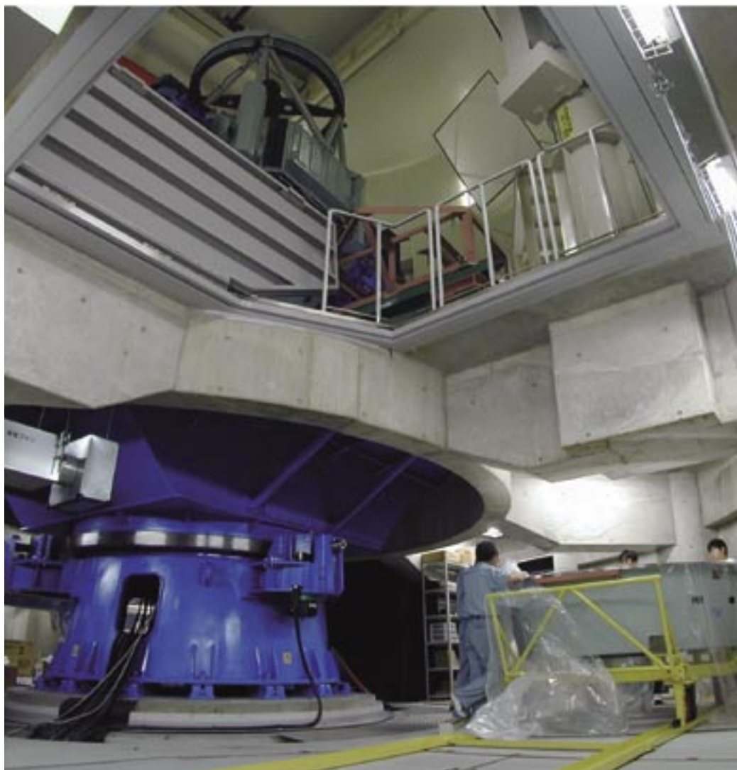
図4：ハッチを通して中3階から3階を見上げた写真。主鏡セルが外されて洗浄台車に搭載されています
