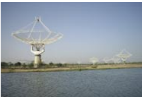
インド国立宇宙電波天文物理センターのGMRT。45mパラボラアンテナが30台ある
