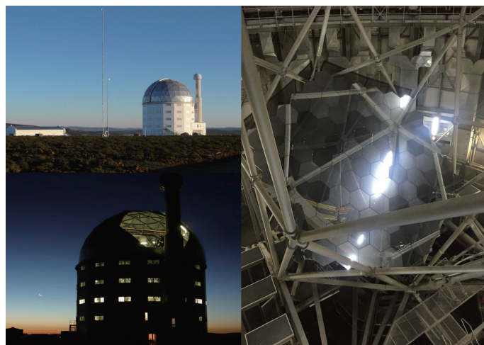
図5：SALT望遠鏡。（左上）外観、（左下）ドームが開いた様子、（右）鏡（©:SAAO）。SALTにくっついた煙突のようなものは、センサーになっており、センサーで主鏡面を精密に測定し、91枚の分割鏡を一つの球面として保つために役立っている。
