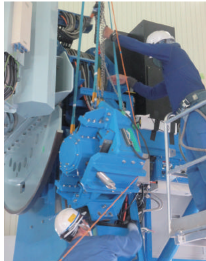
クレーンを使ってモーターを取り外す。入り組んだ場所からモーターがひっくり返らないように計算をしてロープを渡す。
