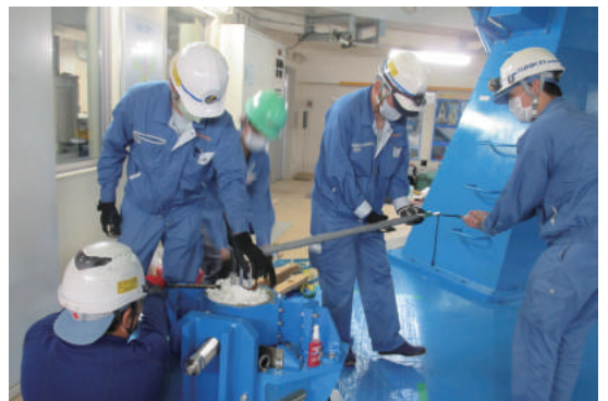
新しいモーターへの付け替え作業。ネジ締めは、長い棒を持って必要な力がかかっているか計りながら回す。モーターが回ってしまわない様にもう一人がパールでモーターを固定。
