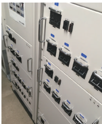
左：制御架付随の 22 個のブレーカー
