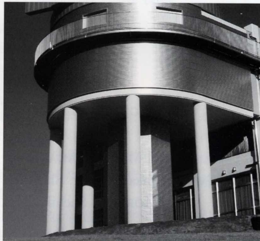
Fig. 23. ピラーを囲むアルミ製ルーバー
