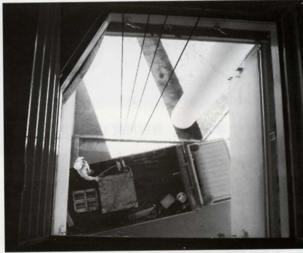
Fig. 15. M3F ハッチを通して地上までフックを降ろしている様子
